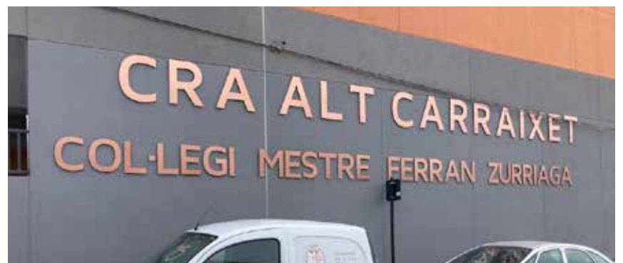
Façana del CRA Alt Carraixet. Olocau. 2023
